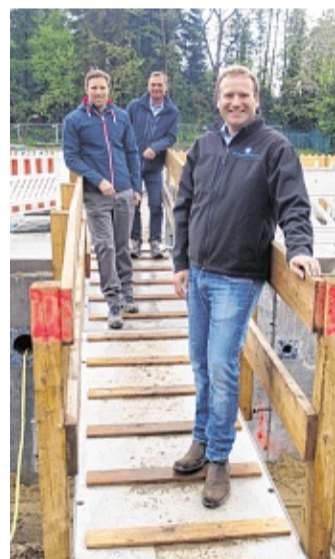
Zufrieden mit den Baufortschritten: Tim Petersen und Kay Fischer von den Gemeindegewerken mit Bürgermeister Jan Butenschön (von links).
