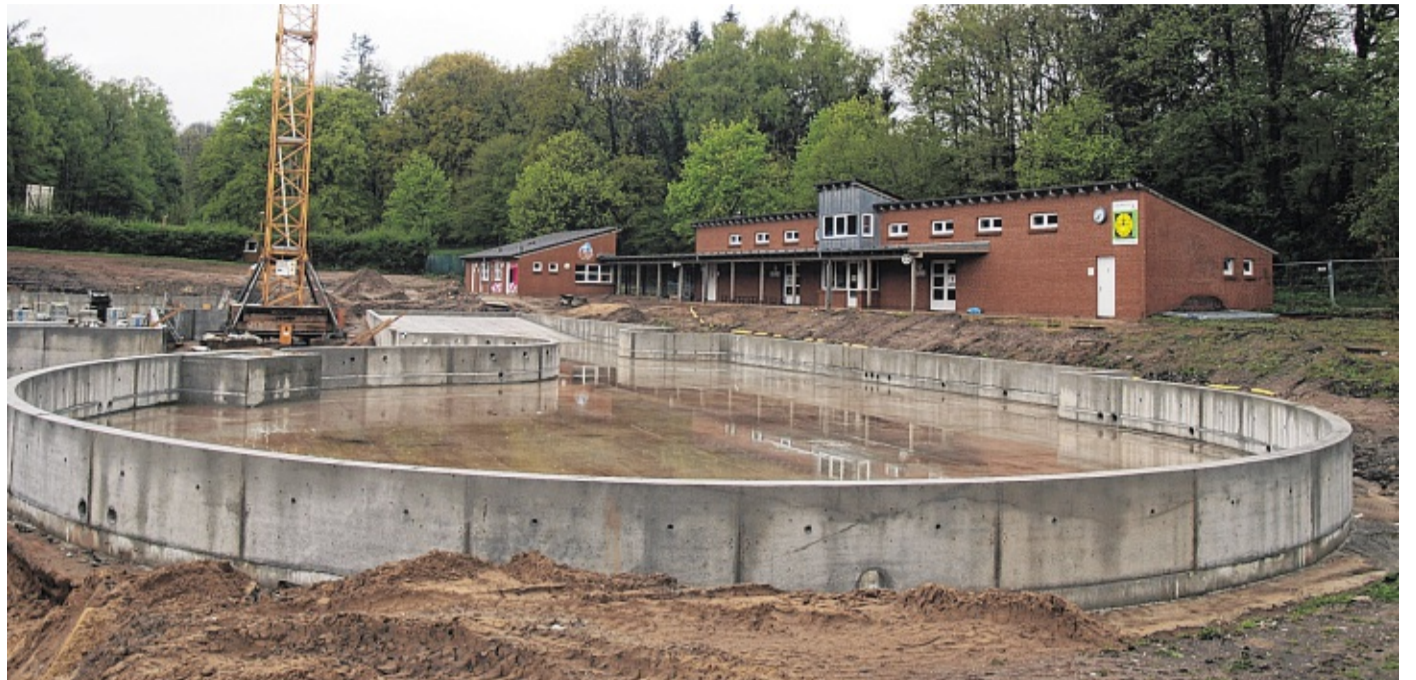
Nimmt Gestalt an: Die Betoneinfassung des Nichtschwimmerbeckens ist bereits fertiggestellt.
